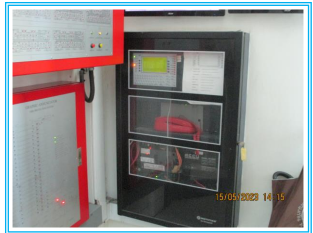
รูปที่ 2.5-9 แผงควบคุมระบบแจ้งเหตุอัคคีภัย
