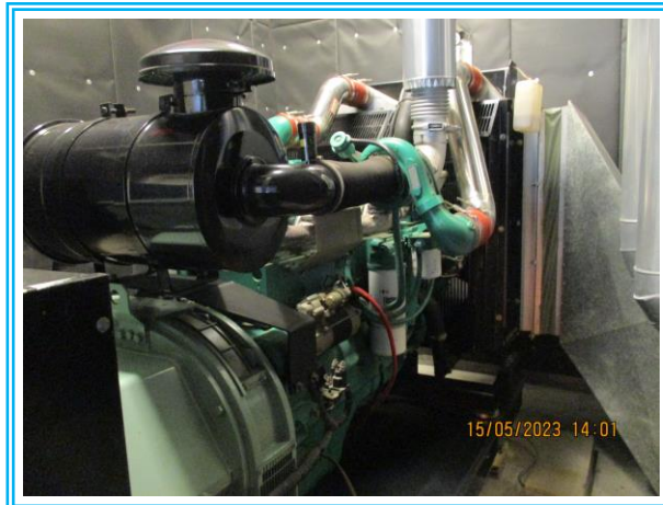
รูปที่ 2.5-8 เครื่องกำเนิดไฟฟ้าสำรอง
