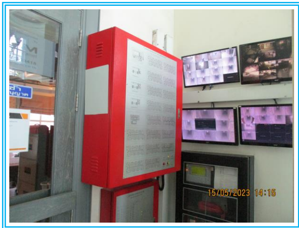
รูปที่ 2.5-9 แผงควบคุมระบบแจ้งเหตุอัคคีภัย
